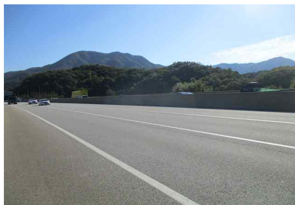
월문3교(서울) 상부 전경
