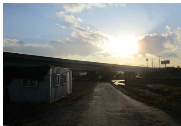
월문3교(서울) 측면 전경
