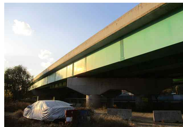
월문3교(양양) 측면 전경
